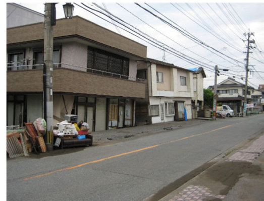
傾斜した建物
